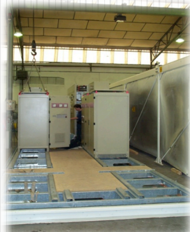
Instalación de equipos sobre estructura base
